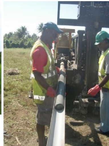
声波钻机打出的“钻芯”
